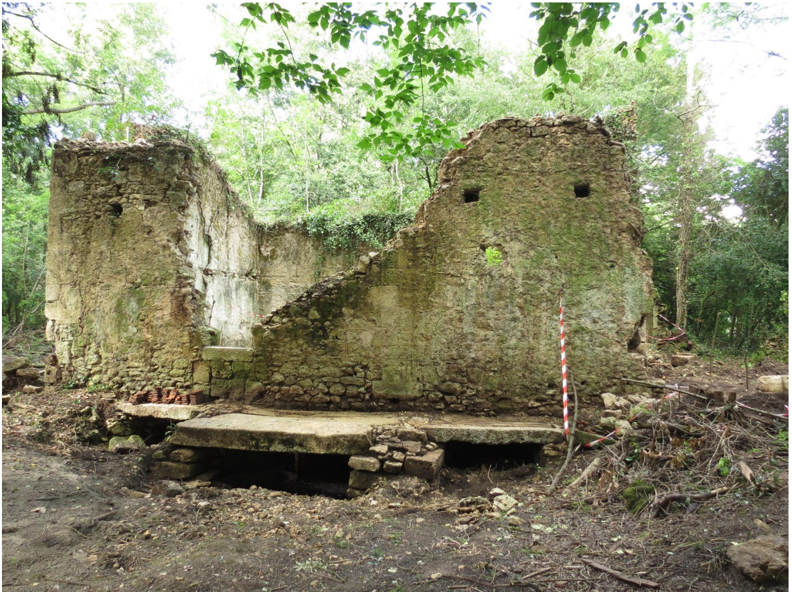
Un mur dégagé.
