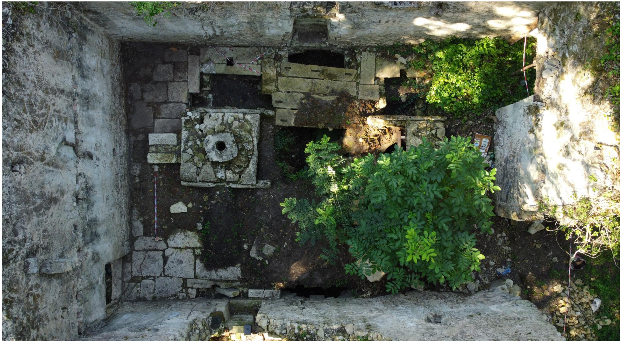
Vue aérienne de l'intérieur.
