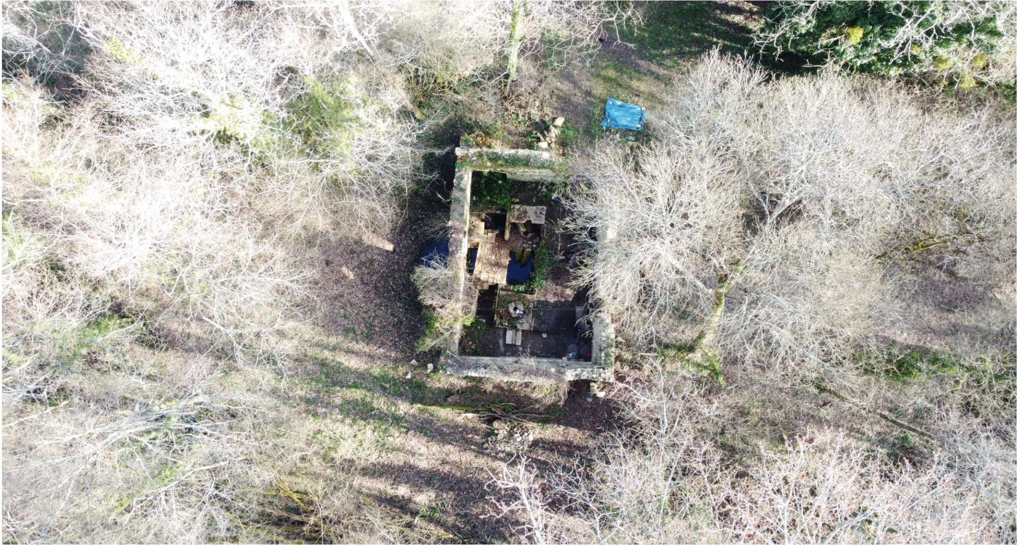
Vue aérienne à plus haute altitude.
