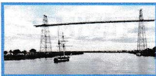
Construit en 1900 sur le projet proposé par Ferdinand Arnodin, il domine la Charente de 50 m, facilitant le franchissement du fleuve sans gêner la navigation fluviale jusqu'en 1967. Il a été remplacé par un pont à travée levante, lui-même détruit en 1991 au profit du nouveau Viaduc de l'estuaire de la Charente. Il reprend du service en 1994 pour les piétons et cyclistes.
